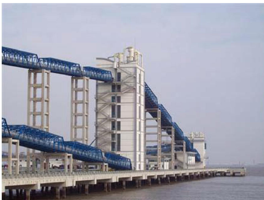
图 6-14 现场工程照片
